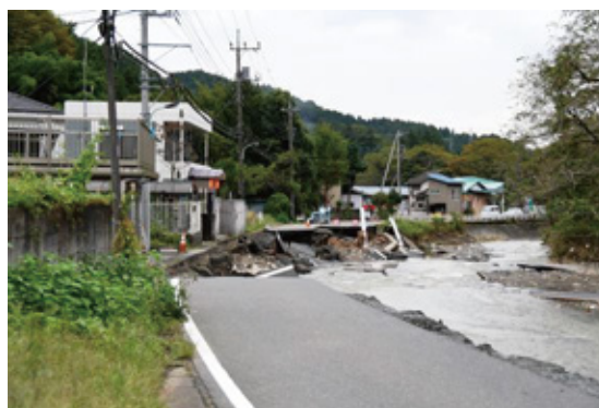
令和元年台風第19号の影響で通行不能となった都道 住民約200人が孤立した（日の出町）
