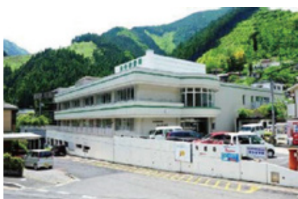
㉒ 奥多摩病院 (奥多摩町)
