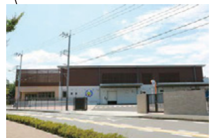
防災機能を備えた給食センター 「防災食育センター」（福生市）
