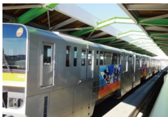
箱根ヶ崎方面延伸事業化に向け調査・設計等に着手する多摩都市モノレール
