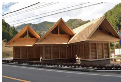
多摩産材を使用した公衆トイレ （檜原村）
